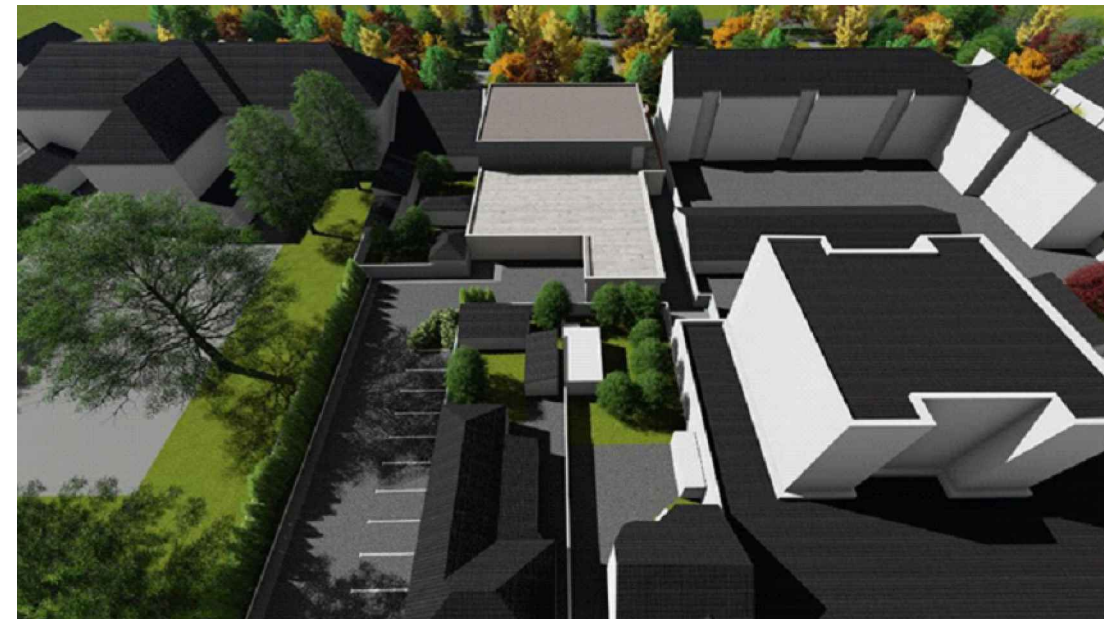
VEDERE AERIANA DINSPRE NORD
